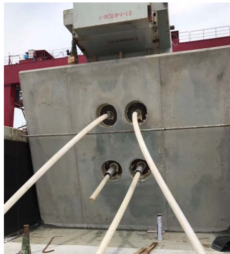
图 4.3.1.7 某桥预制盖梁深埋锚锚具
