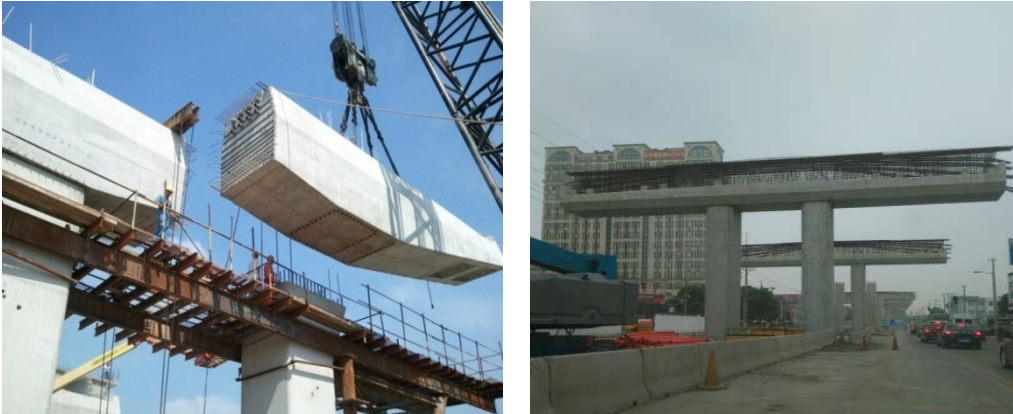
图 4.3.1.1 盖梁分段预制示意图
