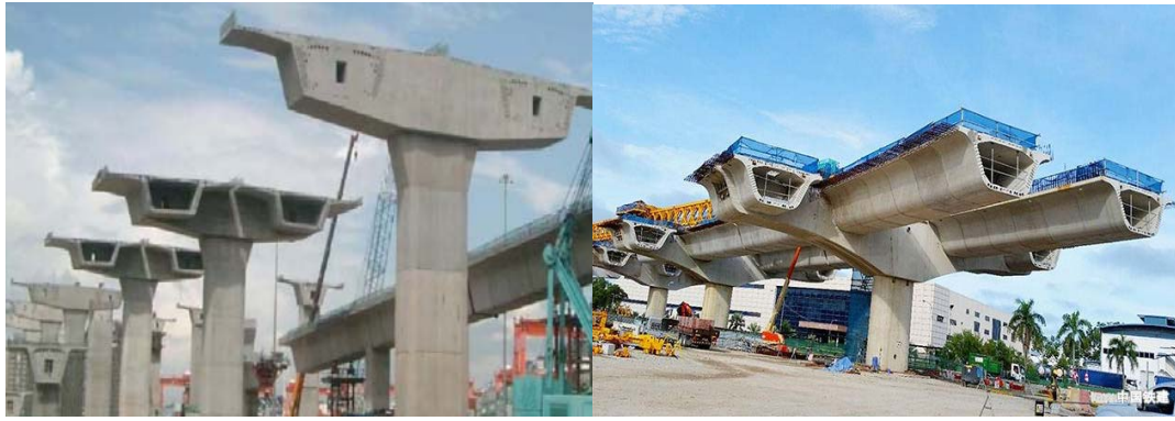
图 4.2.1.2 悬臂吊装节段预制梁
