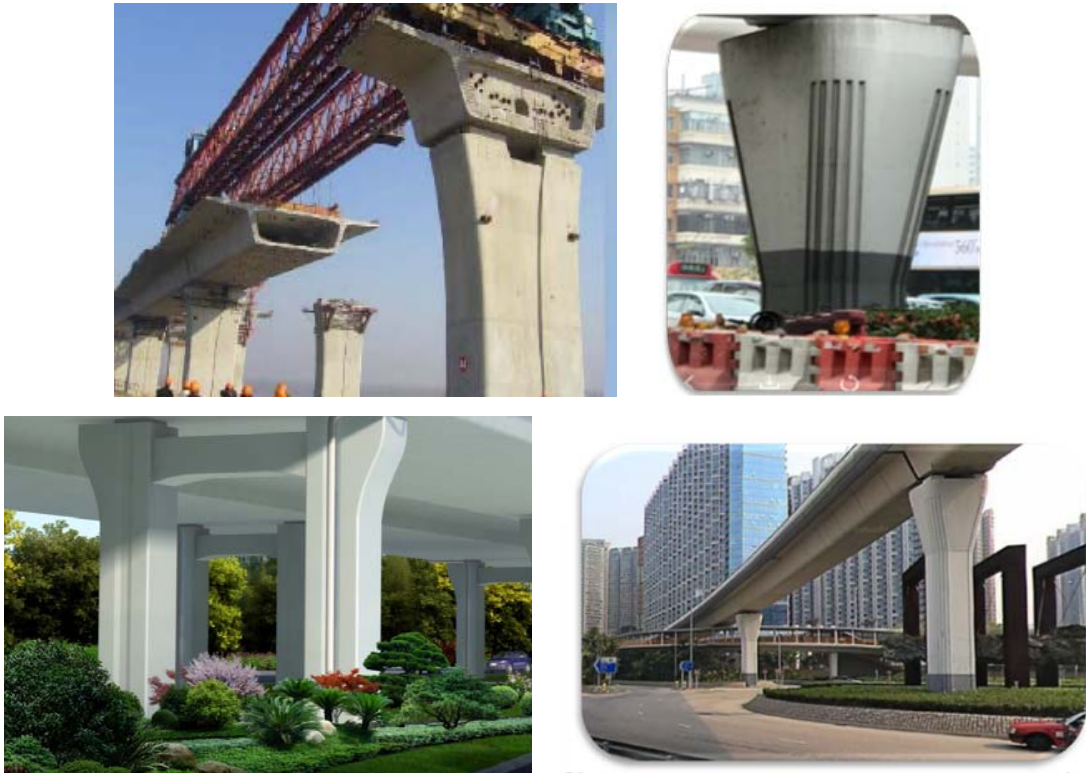
图 3. 5. 8 宽大桥墩刻槽示意图
