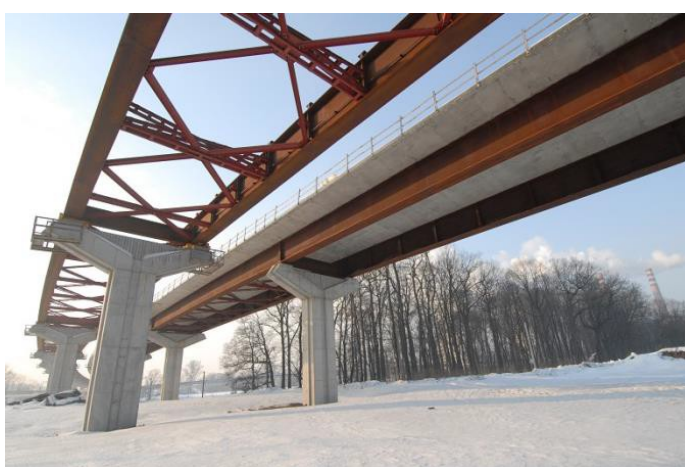
图 4.2.4.4 组合钢板梁实桥图
