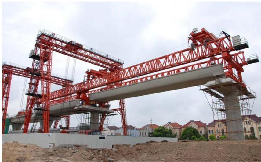
图 4.2.1.3 架桥机吊装预制整孔大箱梁
