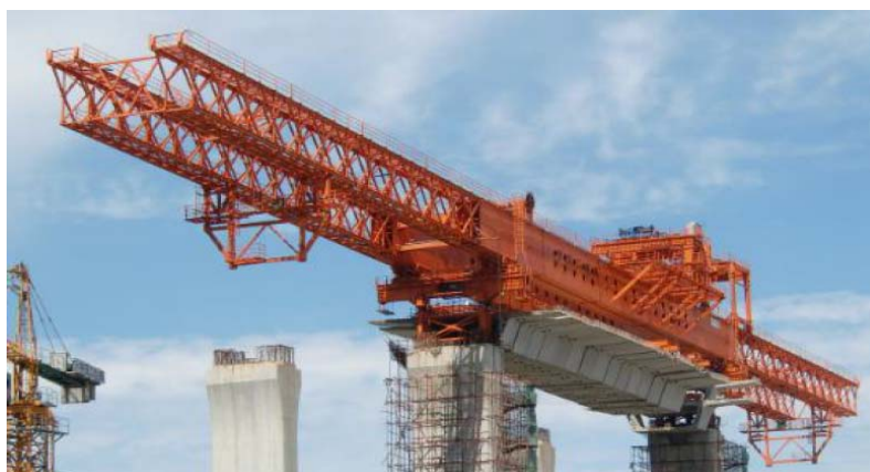
图 4.2.1.1 架桥机架设节段预制梁
