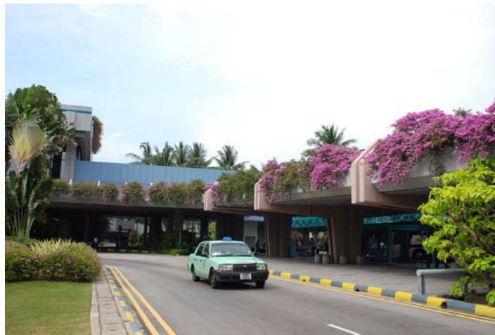
图6.1.2桥梁立体绿化实例
