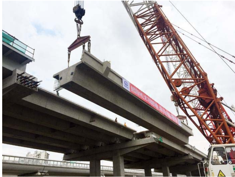
图 4.2.1.4 小箱梁与防撞栏杆整体吊装示意图
