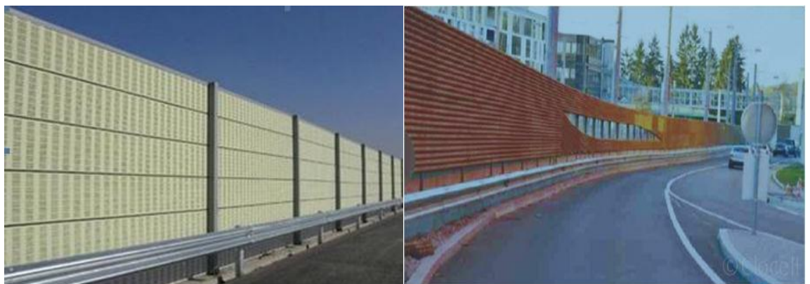
图 5.5.5 木丝砼结构直立型声屏障
