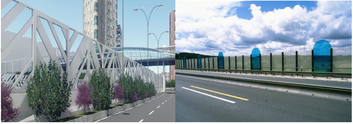
图 5.3.1 直立隔声型声屏障
