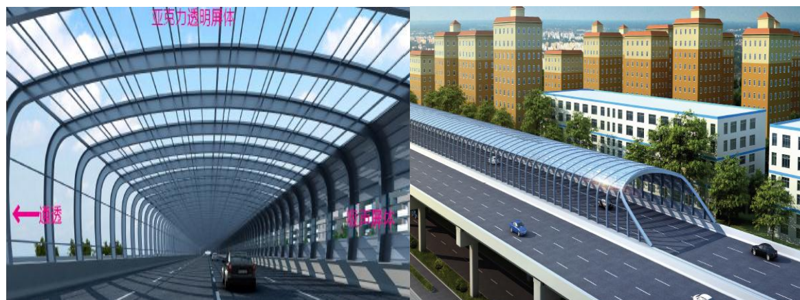
图 5.5.2 半封闭型声屏障
