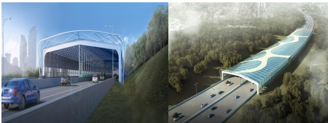
图 5.5.1 全封闭型声屏障
