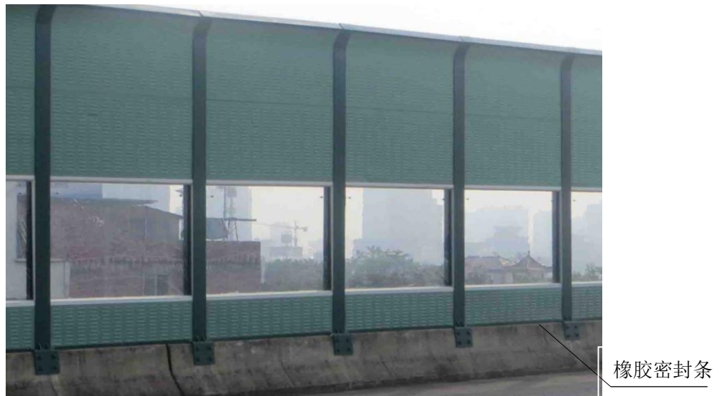
图 6.9.2 声屏障底部连接实景图
