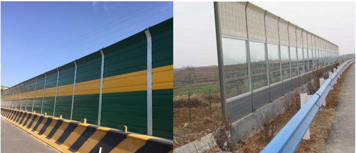
图 5.5.4 直立型顶部圆弧结构直立型声屏障
