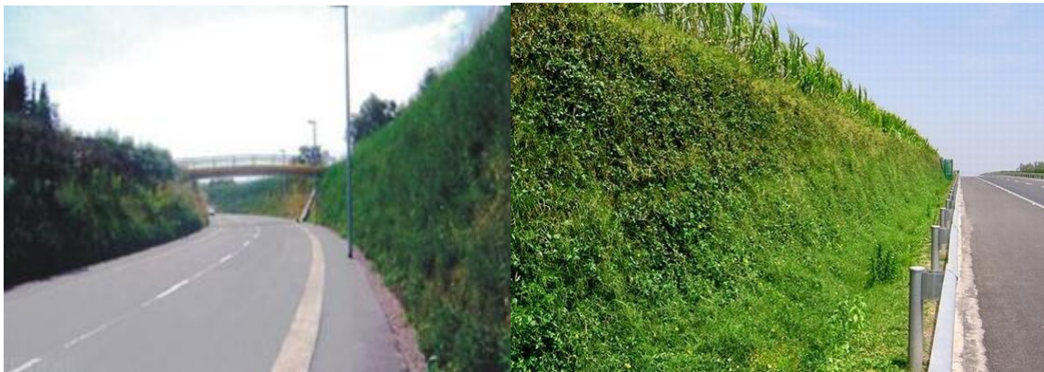
图 5.5.6 软表面绿植型声屏障
