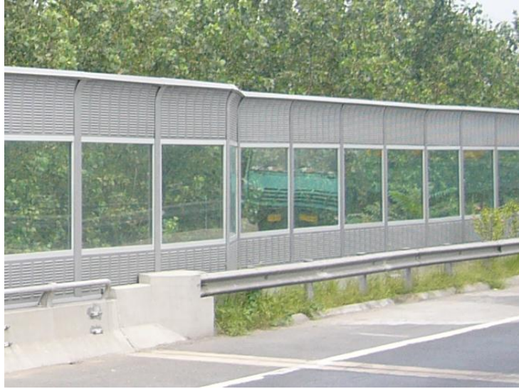
图 6.8.2 声屏障过渡段结构实景图
