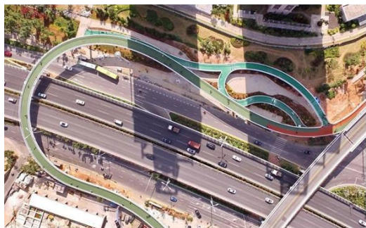
自行车立交桥通道
