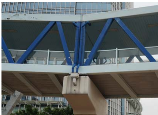
图7.2.5.3 顶棚两侧排水
