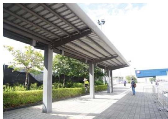
图4.1.5.3 不透光顶棚示例
