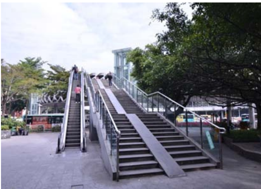
图 3.0.7.1 天桥自动扶梯与电梯
