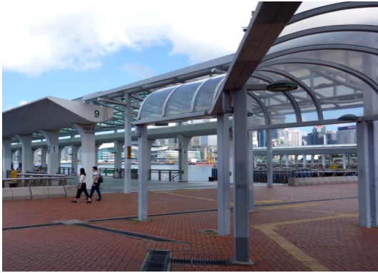
图7.2.5.1 顶棚两侧排水
