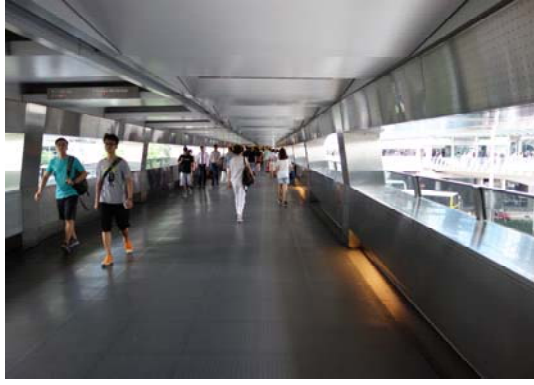
图4.1.5.1 香港中环某天桥顶棚内景(金属板材吊顶)
