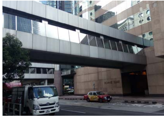
图4.1.5.2 香港中环某天桥屋顶外景(铝合金幕墙)
