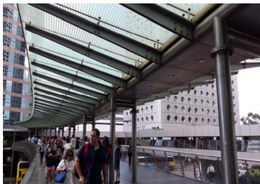
图4.1.5.4 香港中环某天桥顶棚（钢化玻璃）
