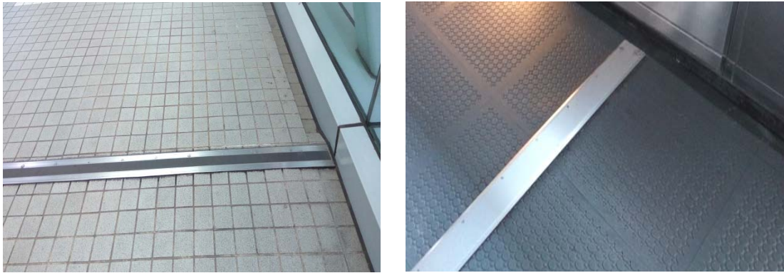
图 3.0.11.3 实桥伸缩缝照片
