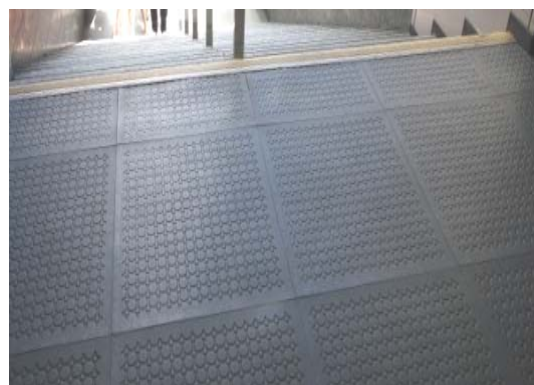
图4.5.2.3 带凸纹瓷砖
