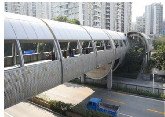
图4.1.5.2 香港中环某天桥屋顶外景(铝合金幕墙)
