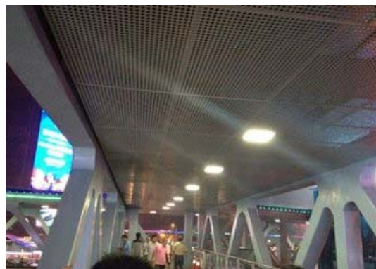
图4.1.5.3 不透光顶棚示例
