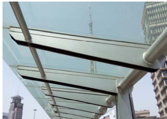
图4.1.5.5 上海陆家嘴某天桥顶棚（钢化玻璃）
