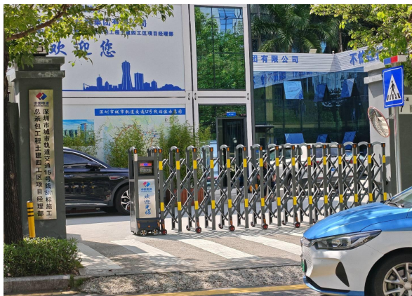
项目进出口位置设置安全警示、凸面镜等设施，路口标线清晰
