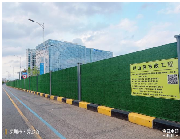
施工围挡顺直、美观，警示灯具设置充分
