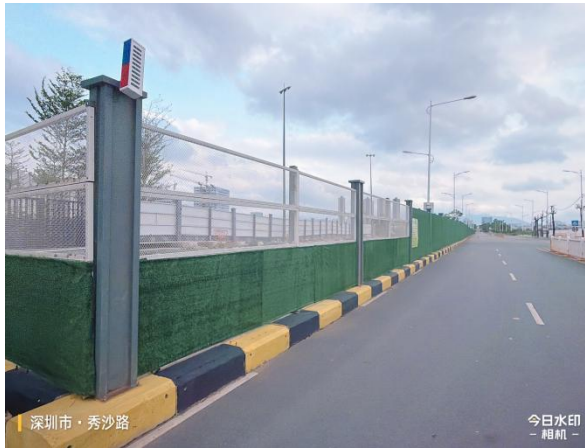
端头拐角位置设置透明式围挡、配置安全警示灯具
